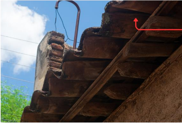
Material | madeira Técnica | madeira não aparelhada Elemento | caibro Tipo | roliço
