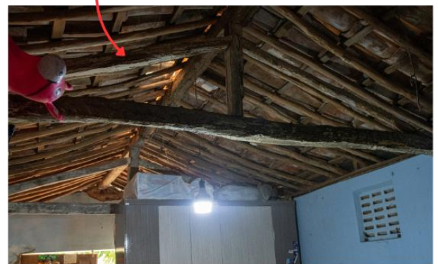
Material | madeira Técnica | madeira não aparelhada Elemento | tesoura | conjunto estrutural triangular
