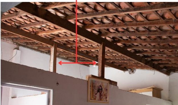
Material | madeira Técnica | madeira aparelhada Elemento | pontaete | apoio vertical de estruturas
