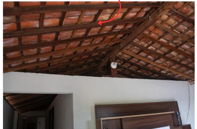
Material | madeira Técnica | madeira não aparelhada Elemento | tesoura | conjunto estrutural triangular
