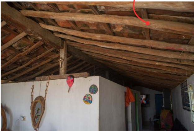
Material | madeira Técnica | madeira aparelhada Elemento | pontaete | apoio vertical de estruturas
